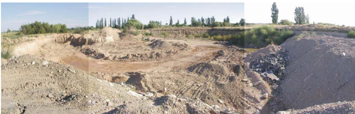
Fotografía 2.3.9- Hueco de antigua gravera con relleno no sistemático con materiales de diverso origen, a 3 km al oeste de Cortes (321-008)
