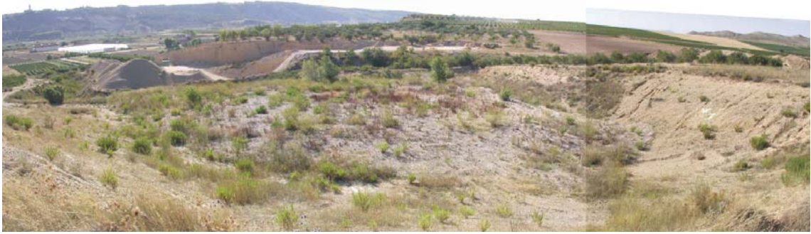
Fotografía 2.3.10- Zona de graveras en ladera frente a Cáscar (al fondo, a la izquierda) con rellenos parciales y suavizados de formas sin aparente orden, donde no se ha recuperado uso alguno para el terreno (en primer plano: 205-021; detrás: 205-004)
