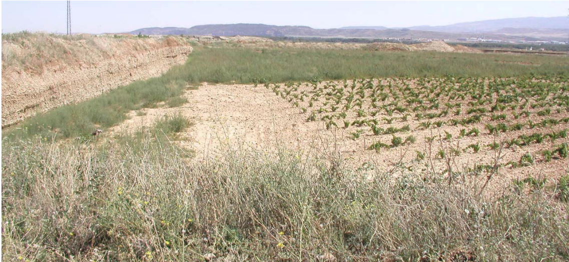
Fotografía 2.3.3- Restauración para uso agrícola, dejando talud subvertical y franja horizontal sin uso agrícola actualmente, a unos 500 al noreste del Centro de Investigaciones Agrarias (hoja 204)
