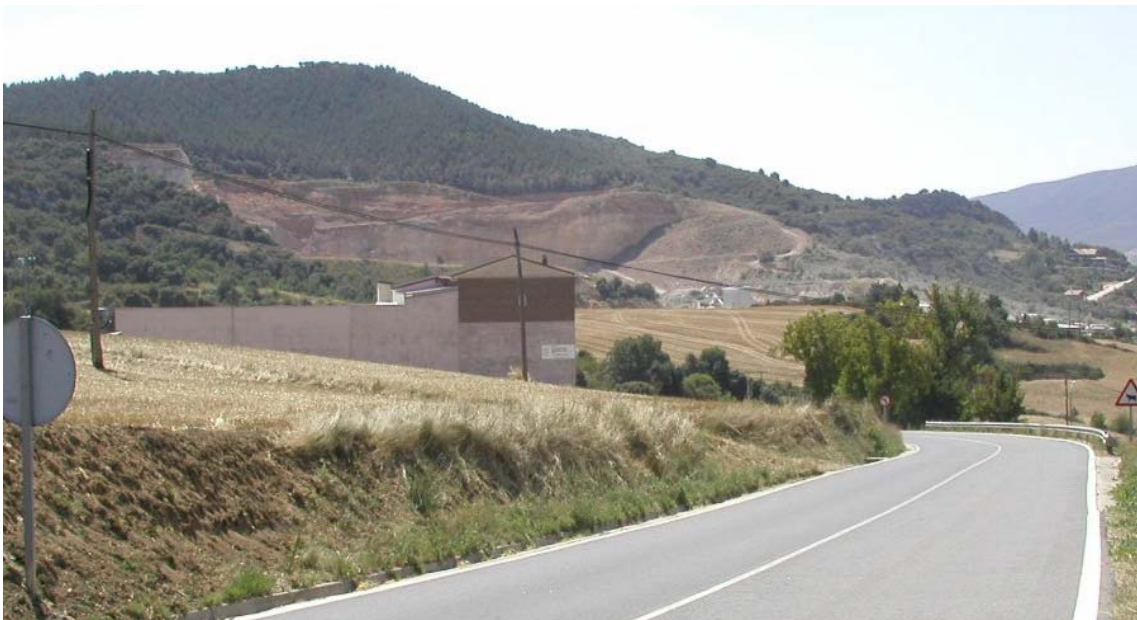
Fotografía 2.1.14- Reperfilado de parte del talud en la cantera 140-005
