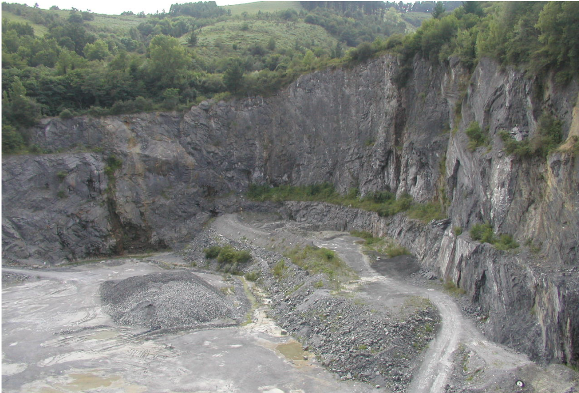
Fotografía 2.1.15- Ejemplo de la generalmente escasa dimensión y utilidad de la colonización espontánea de frentes (cantera 065-003)
