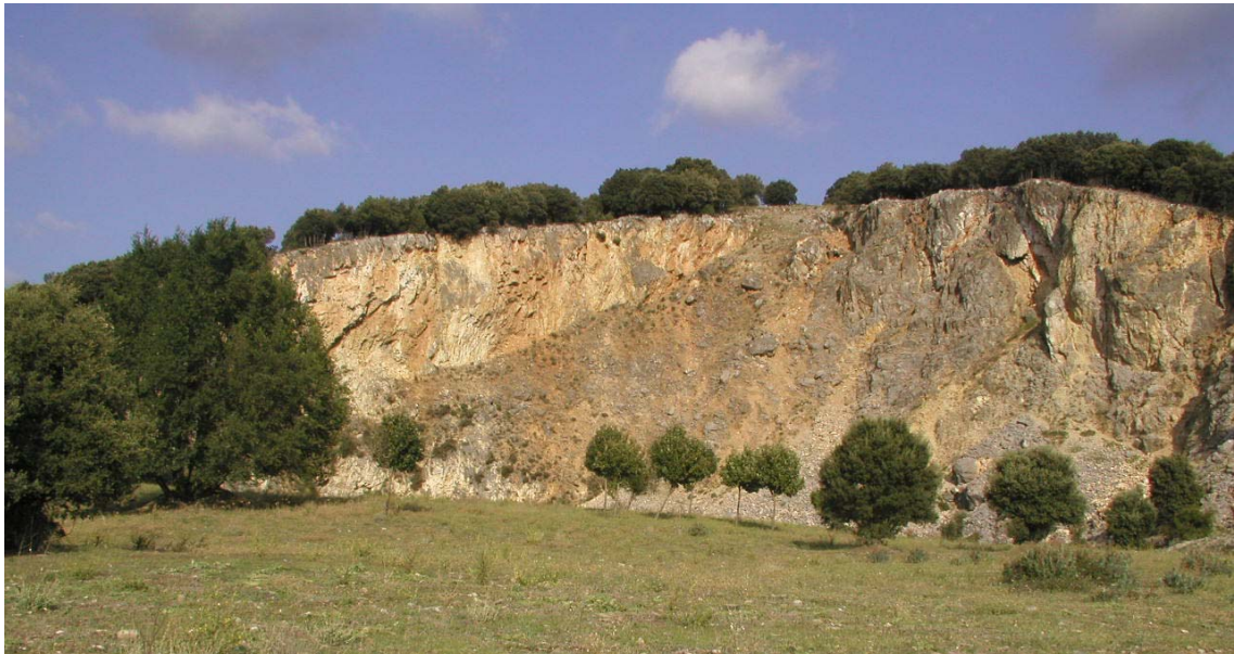
Fotografía 2.1.5- Frente con cierta integración cromática debida fundamentalmente a características propias de material que se explotó y, en menor medida, a la antigüedad del talud. (Cantera inactiva 115-007).
