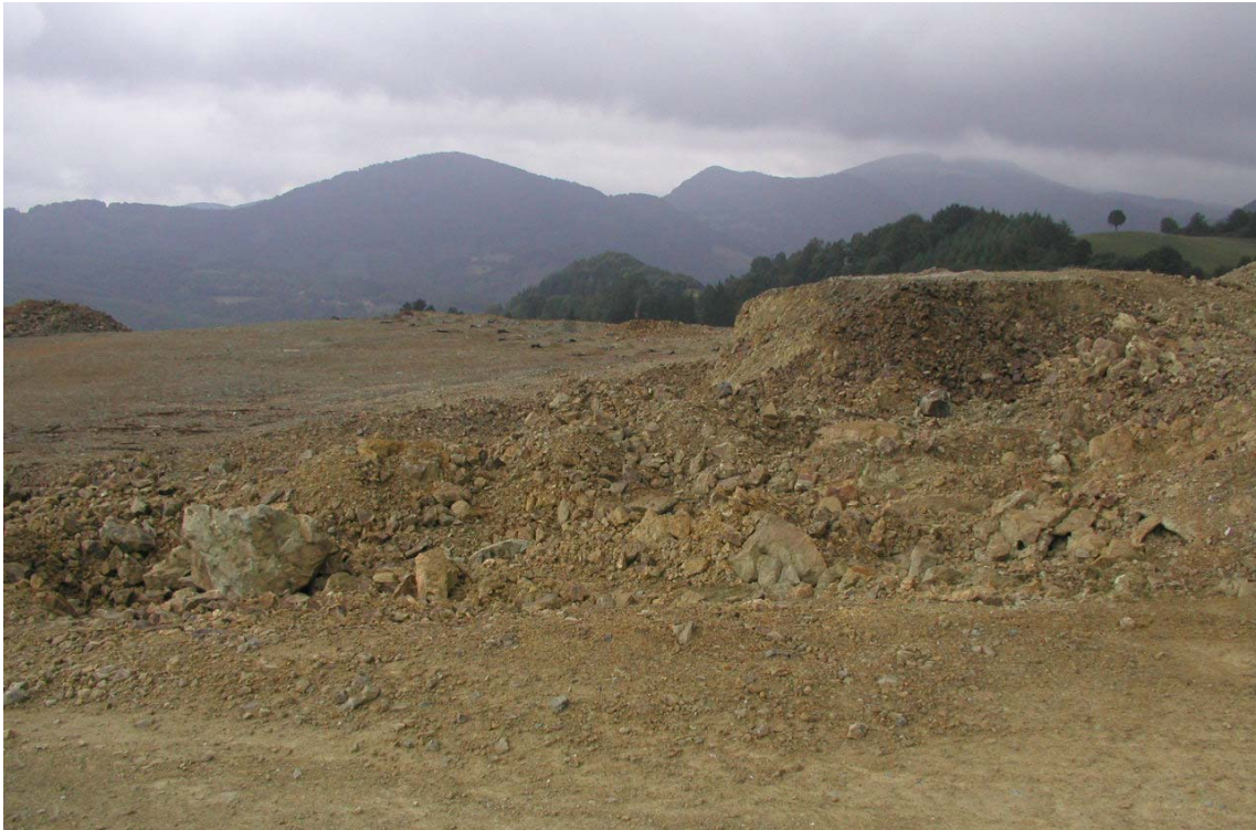
Fotografía 2.2.3- Parte superior de la cantera de ofita 090-008
