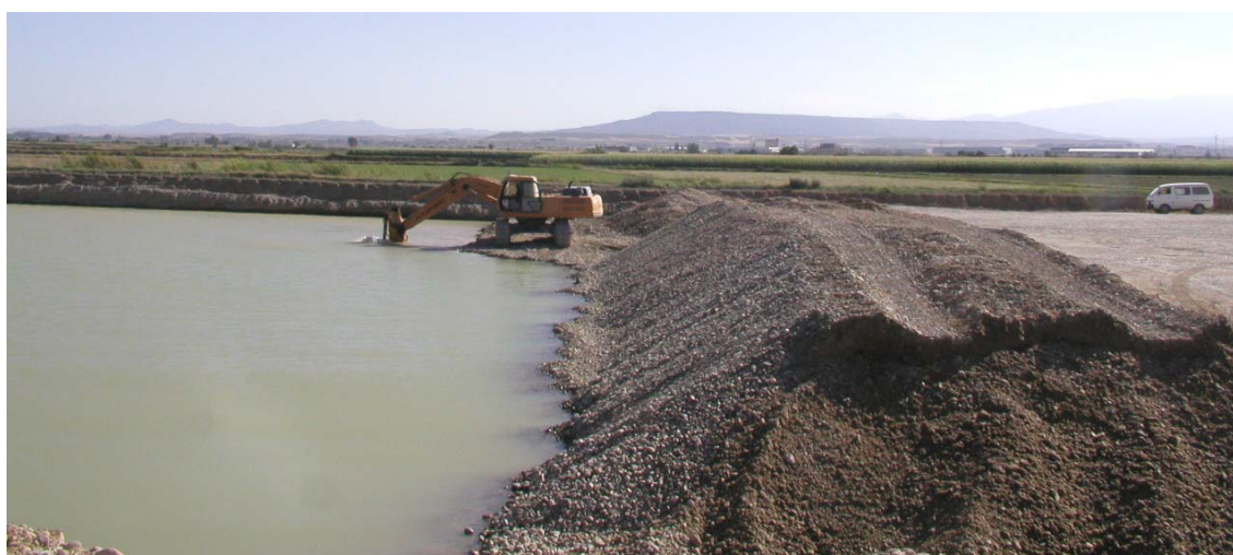
Fotografía 2.3.1- Gravera con explotación bajo nivel freático. (321-005)
