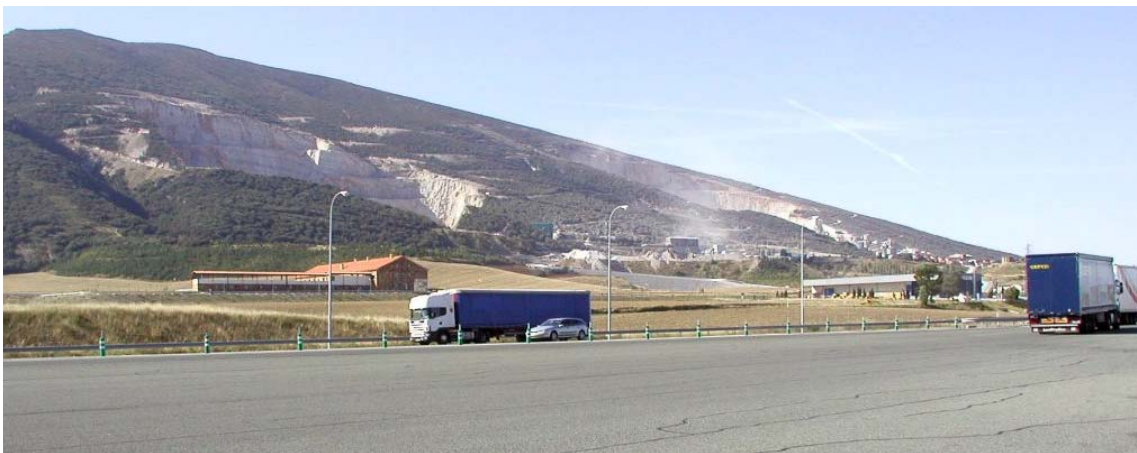
Fotografía 2.1.3- Canteras 141-006 y 141-009 (Alaiz) desde la autopista A-15
