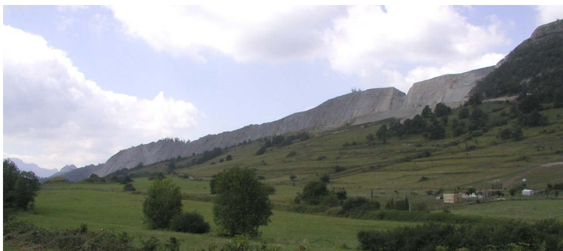
Fotografía 2.1.8- Vista general del talud principal de la cantera 113-001.
