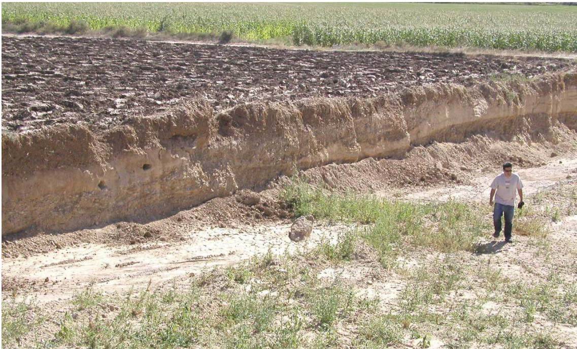
Fotografía 2.3.4- Antigua gravera a casi 3 km al noreste de Peralta (206-002) con restitución topográfica dejando talud subvertical, y donde puede apreciarse la actual diferencia entre el suelo original y el dejado tras explotación.
