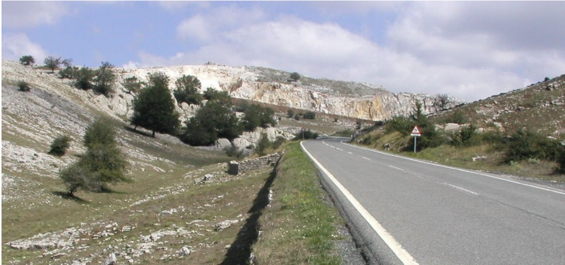
Fotografía 2.1.2- Cantera 114-007 (Urbasa) desde el sur.
